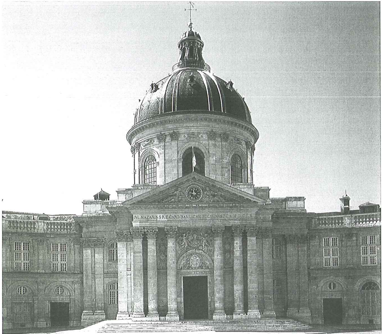
Louis Le Vau, Collège des Quatre Nations (ora Institut de France) a Parigi, 1662-1670.
