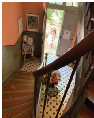
從1樓入口連接到2樓的樓梯「鑄鐵鐵欄杆」木頭扶手優雅的順著階梯上到2樓，地板馬賽克磁磚、牆面、梯面的配色跟我們台灣常用的用色很不一樣。
