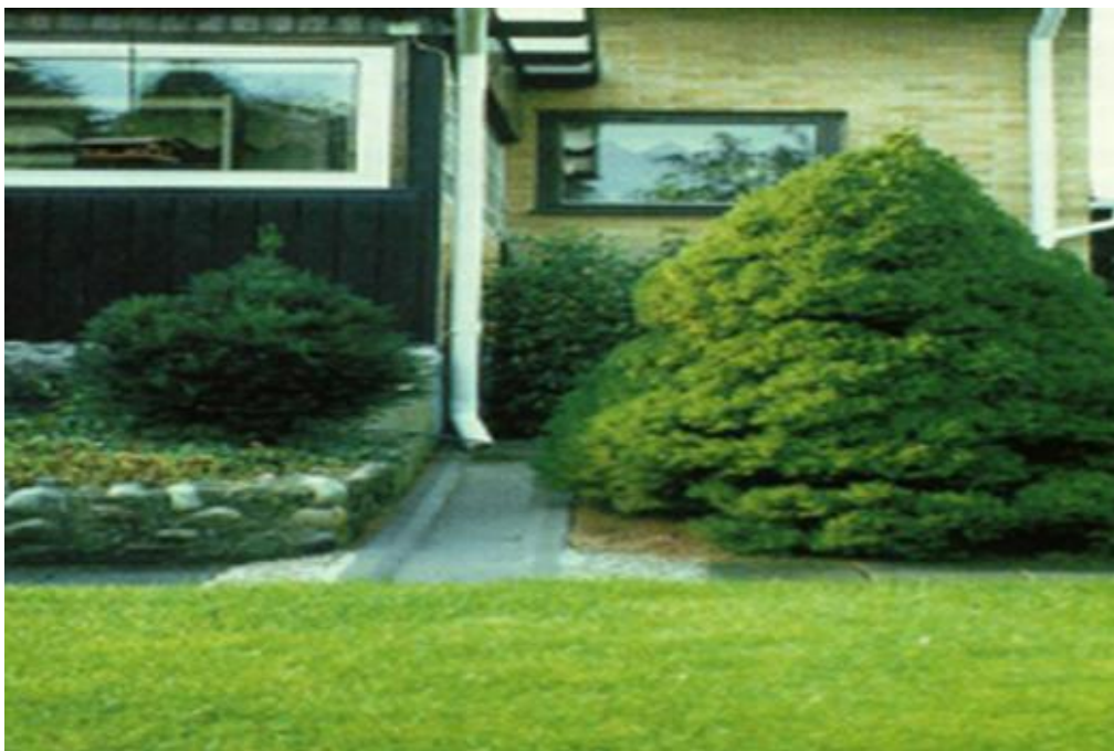
7. ábra: A tetővíz levezetési útvonalánál megszakítása
