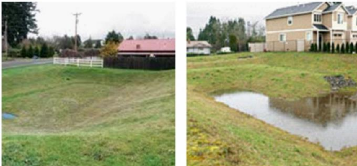
32. ábra: Beszivárogtató tó száraz és nedves állapotban
