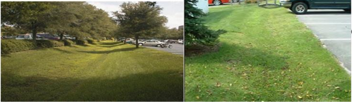
18. ábra: Kisforgalmú utak és parkolók vizének elszikkasztása füvesített árokkal, illetve faárokkal
