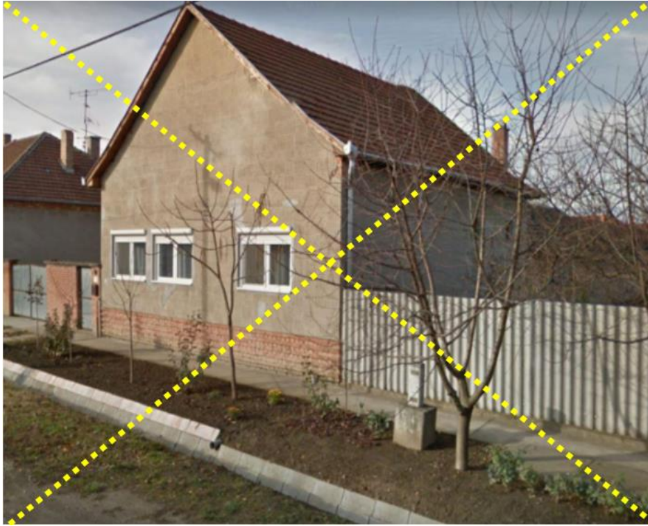
15. ábra: Műszakilag helyes, de a csapadékvíz gazdálkodást mellőző kivezetés.
