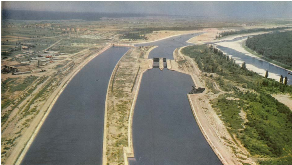
FIG. Les écluses et l'usine d'Ottmarsheim (Haut Rhin), Le Rhin , Paris, La documentation photographique, 5-219, 1961. « A droite l'ancien lit du fleuve bordé de digues, encombré de bancs de sable et de graviers ; au centre le canal de navigation et les deux écluses... ; à gauche, le canal de force motrice qui conduit à l'usine électrique dont la production moyenne annuelle, sous une chute de 14,70 mètres, est de 900 millions de kWh », soit 2,3% de la production hydro-électrique française.
