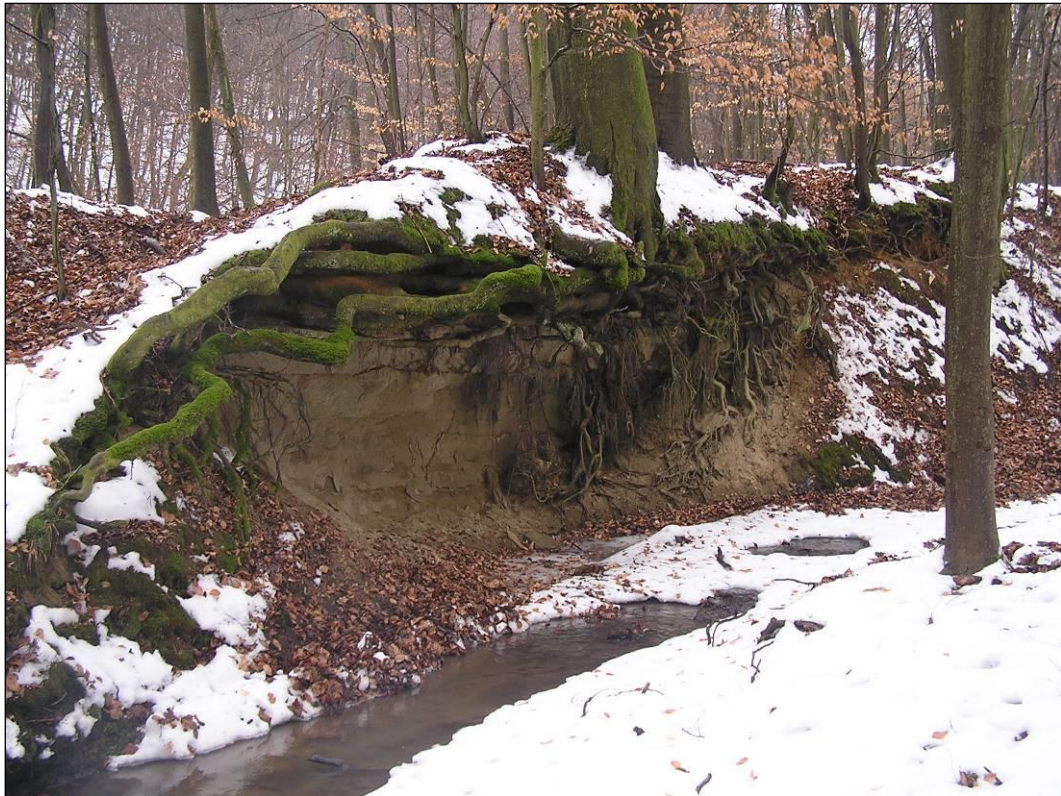
11) kép: Erodálódó mederfal a Gortva-patak folyásának alsó szakaszán, az égerliget-állományok közvetlen szomszédságában (Salgótarján 452/A; KE-5)
