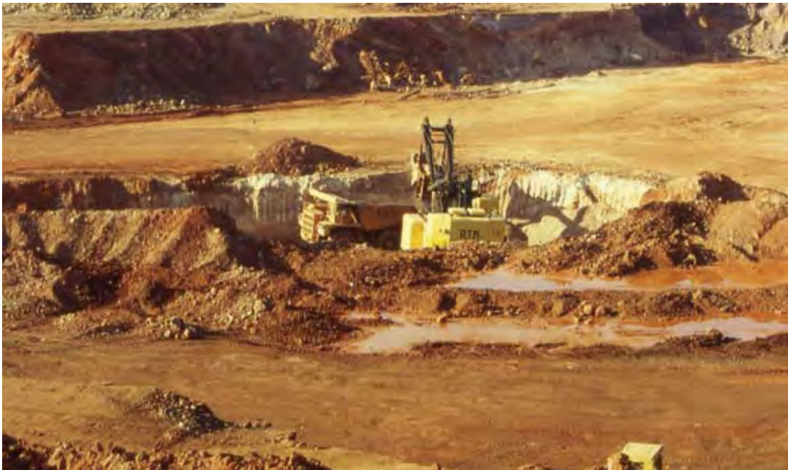
Trabajos en Cerro Colorado a mediados de los años 80. AFRT
