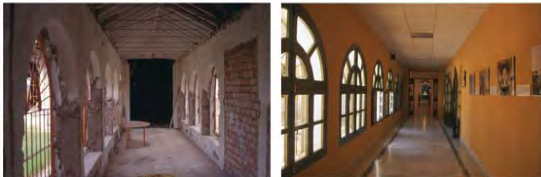
Rehabilitación del pasillo central y estado actual. AFRT
