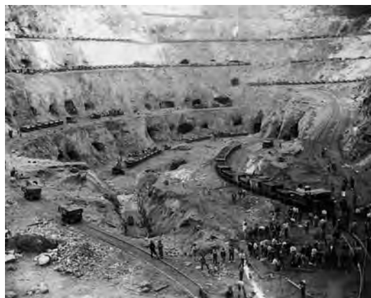
Explotación "a cielo abierto" u "open pit system" principios del s. XX. AFRT
