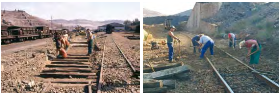
Trabajos de restauración del trazado viario. Foto AFRT.
