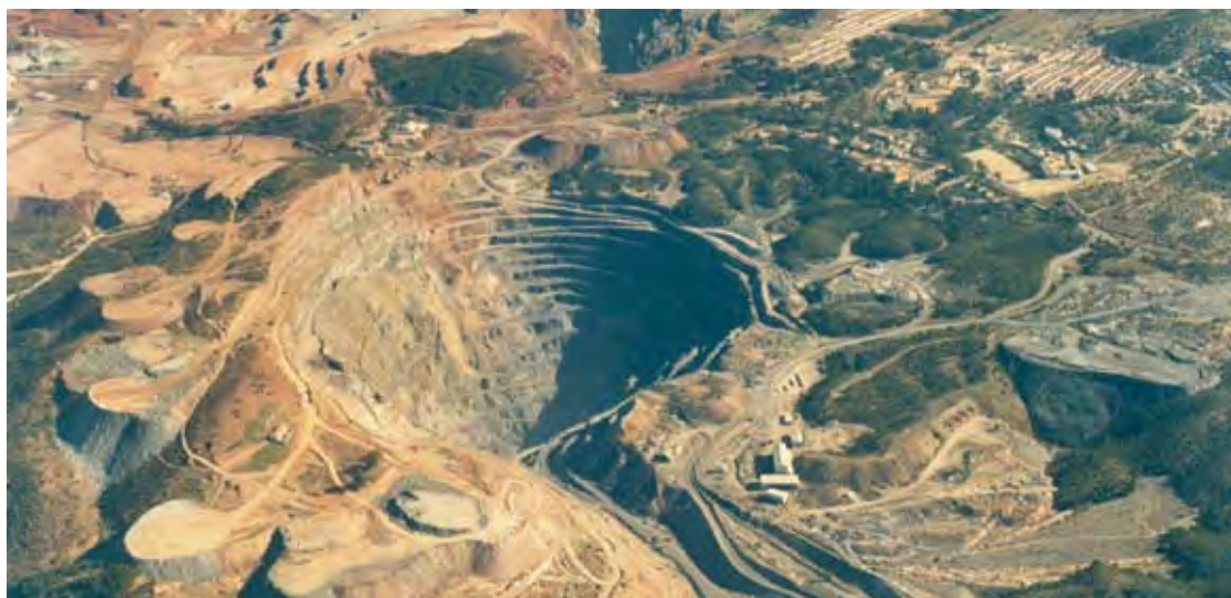
Vista aérea de los trabajos en Corta Atalaya y Cerro Colorado a fines de los años 70. AFRT.
