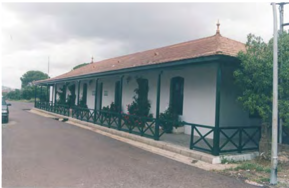
Edificio del Archivo Histórico Minero. AFRT.
