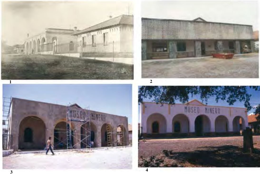
Evolución del exterior del edificio que albergó el hospital desde su construcción (1), hasta principio de los años 80 (2) y su transformación posterior (3) en el actual Museo (4). AFRT
