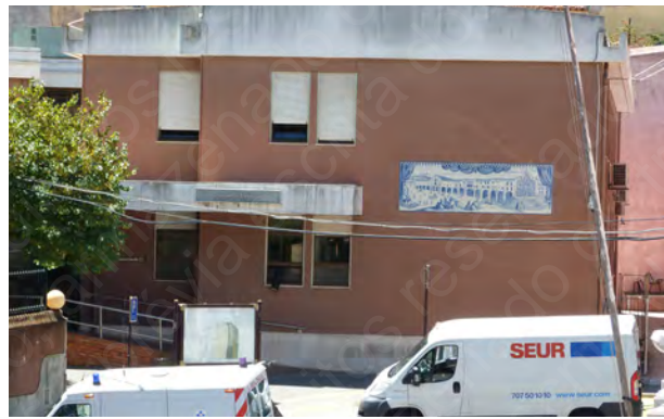
Pavilhão das consultas do H. S. José
