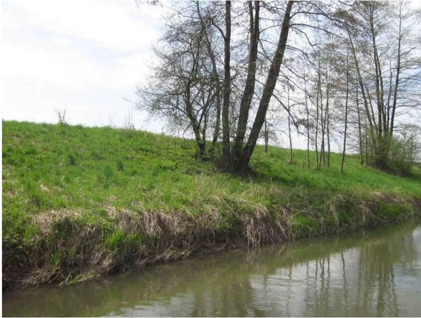
Obrázek č. 16: Terénní vlna severně u Horky nad Moravou.
