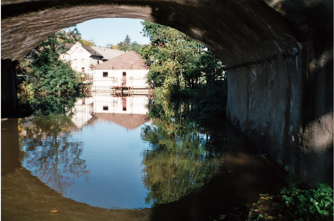
Obr. 5 Pohled na malou vodní elektrárnu z oblouky bývalého Krasíkovského mostu (Vladislav Kyselica, 2009)
