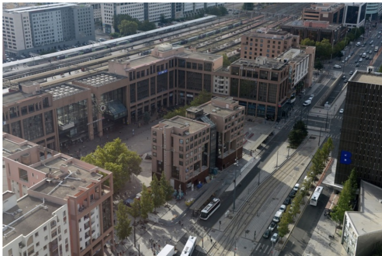
65_ Fotografia edificio B10 prima della demolizione, avvenuta tra il 2014 e il 2015.
