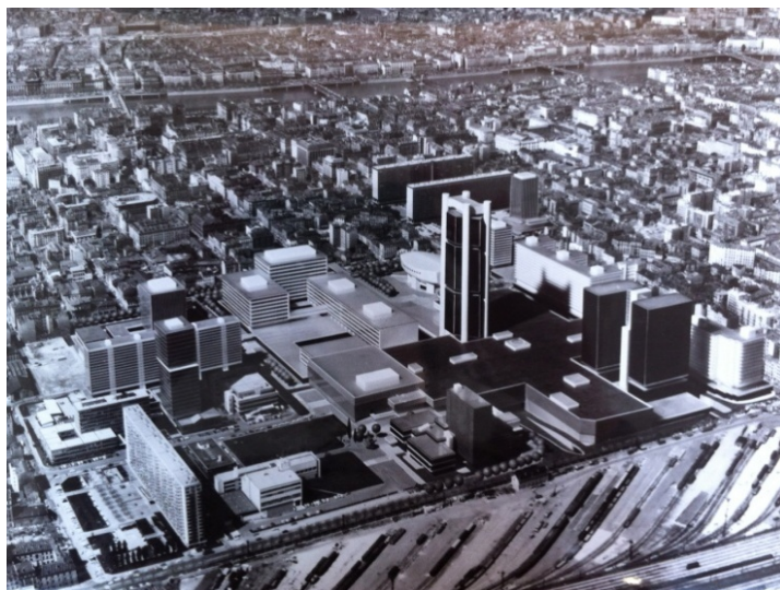
15_ Photo-montage de l'ensemble de l'opération dans le site. Novembre 1972. AML, 111 II 016.
