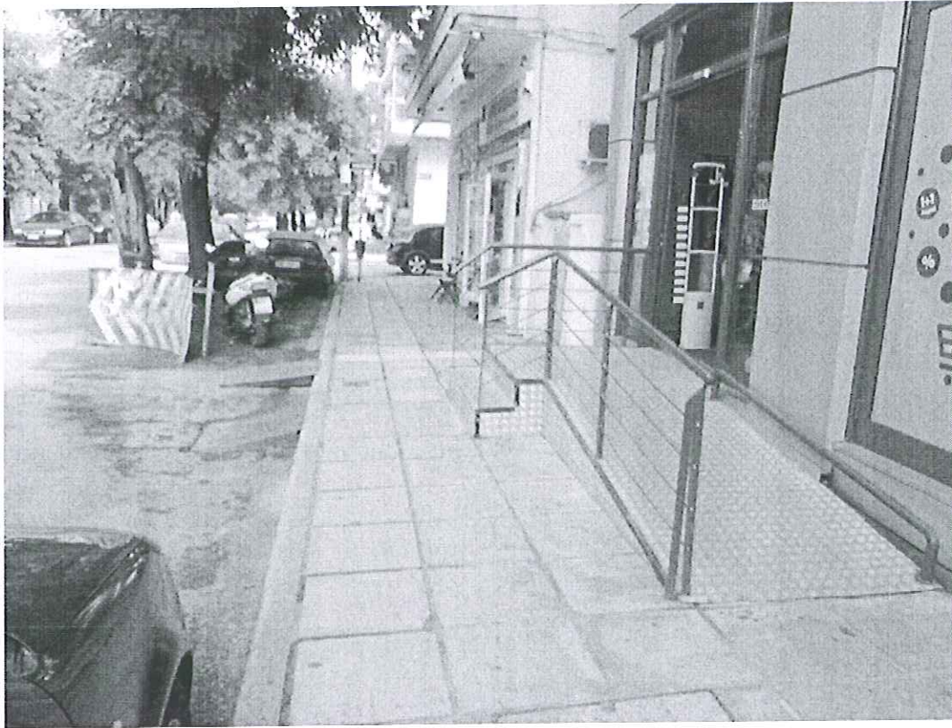
Εικόνα 4: Μεταλλικές ράμπες προς καθαίρεση στην Παπάφη 51-53
