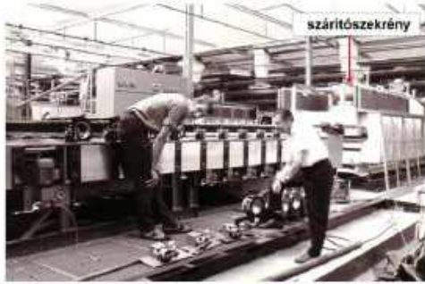
STORK rotációs filmnyomógép telepítése 1971 körül a Textilfestőgyárban, a készülő szárítószekrény STORK-KAEV típusú
