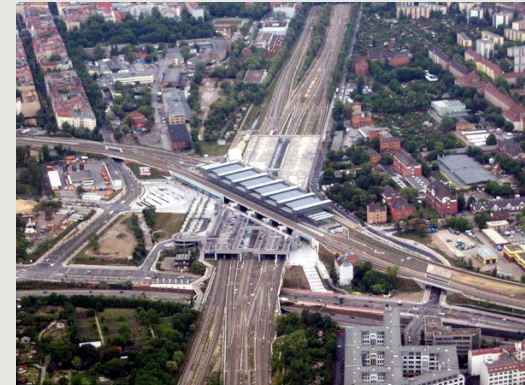
Sub-center station: Berlin Südkreuz.
