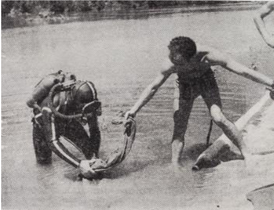
Búvár általi fólia fektetés (Dégen, 1996)
