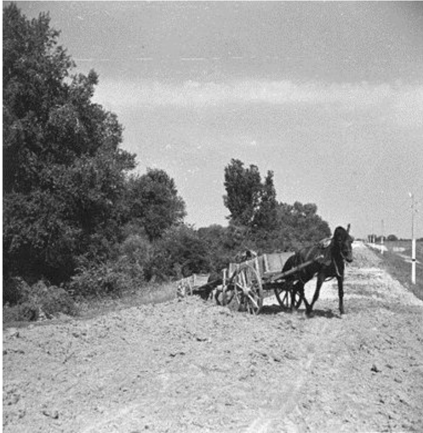
5. ábra - Töltésépítés az 1956-os árvíz után [Forrás: ADUVIZIG archívum]
