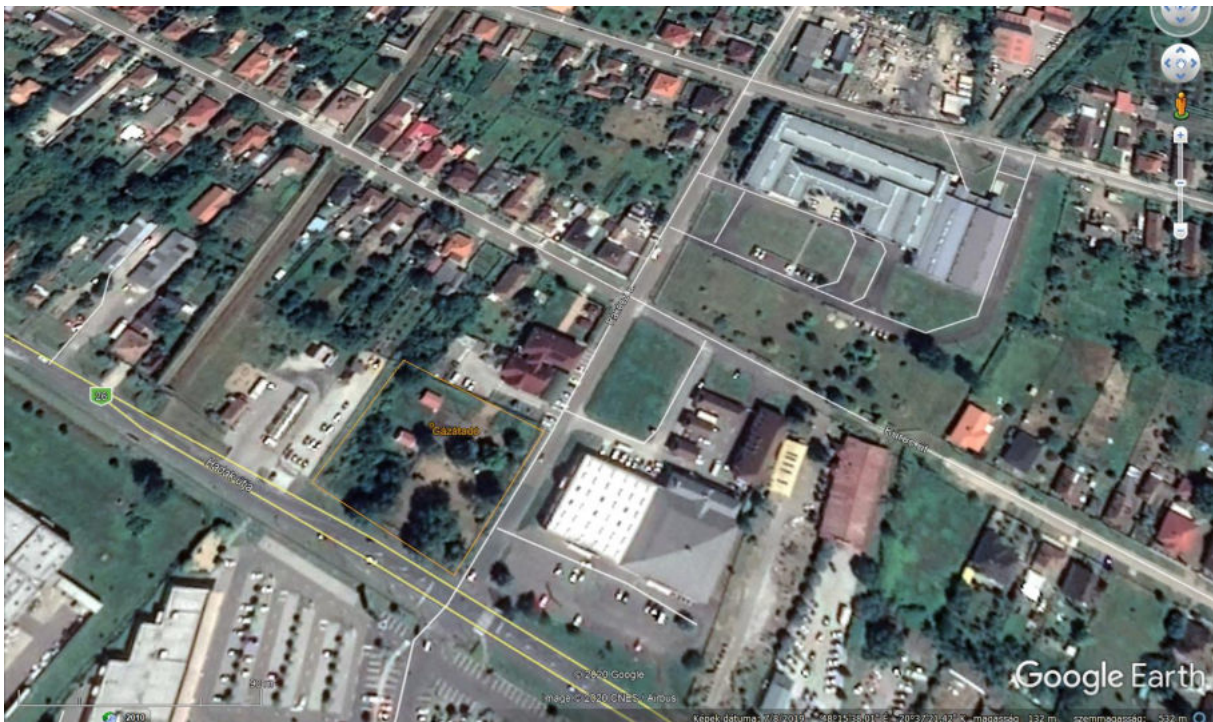
7. ábra: Gázátadó állomás, készítette: Cimer Zsolt.
