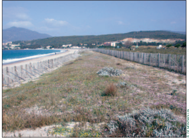
Protección de la costa por encima del nivel de marea alta, Ajaccio, Córcega
