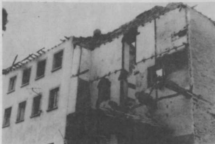
En este estado quedó la «Casa el Conde», después del fatal incendio
