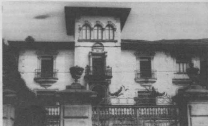
Chalet del Soliso: En inminente peligro de derribo. En aras de una mayor especulación, el Plan debería proteger este tipo de edificaciones.
