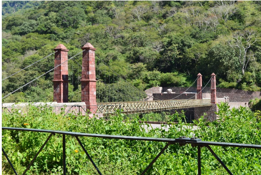
Figura 66. Actual puente de Arcediano 2015 (Fotografía A. Chávez)
