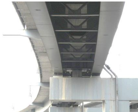
Foto 43. Traveses compuestas paralelas con columna en acero
