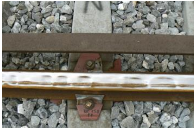
Foto 24. Fijación Nabla rotas en PK 11,780
