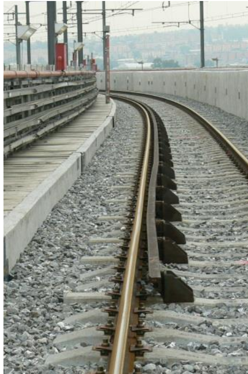
Foto 12. Contra-riel de la curva 27 vía 2
