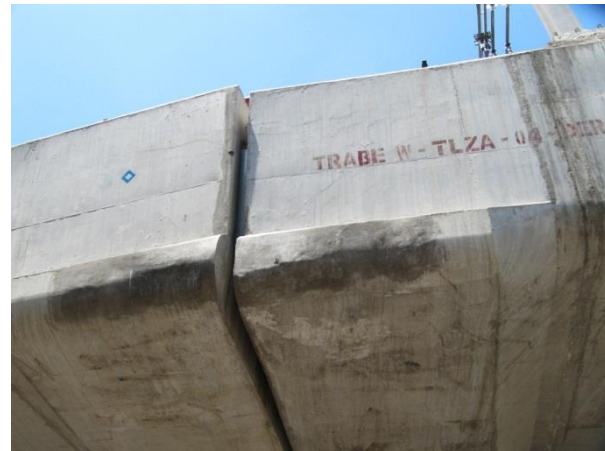
Foto 52. Irregularidad de geometría de los segmentos y tramos prefabricados
