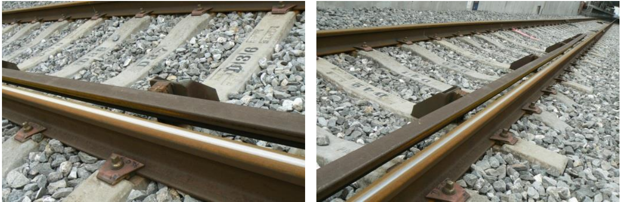
Foto 13. Trazas de fricción (zona activa del contra-riel) comprendido entre el 3° y el 6° soporte (curva 27)
