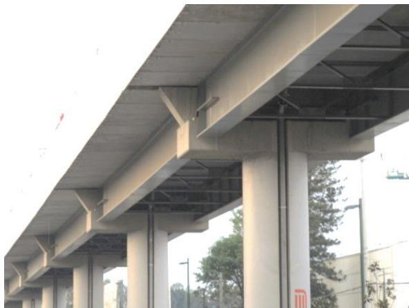
Foto 42. Trabe compuesta con columna en hormigón
