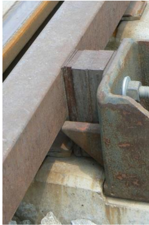
Foto 15. Apoyo del contra-riel sobre 3 mm en extremo del soporte (curva 3)
