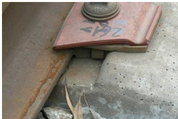
Foto 26. Fijación colocada con dos láminas de resorte en el PK 4,985
