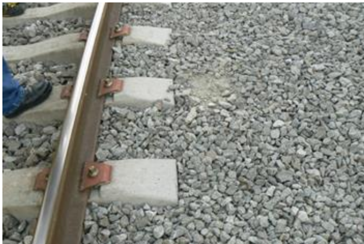
Foto 32. Elementos finos en el balasto PK 6,015 vía 2
