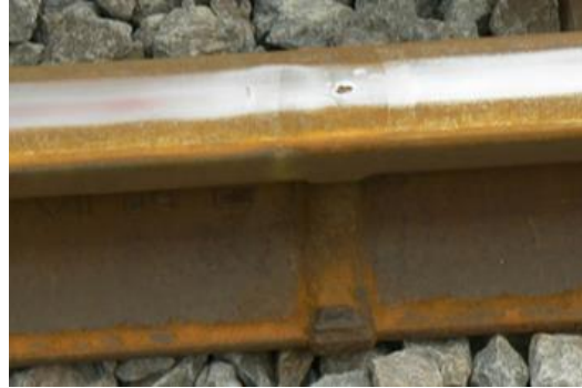
Foto 10. Soldadura PK 16,820 vía 2
