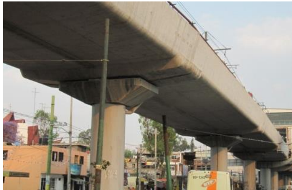
Foto 44. Traveses de hormigón en doble U con columna en hormigón
