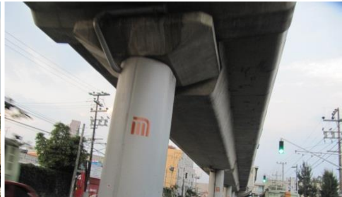
Foto 45. Trabe de concreto en U con cajón y columna en hormigón
