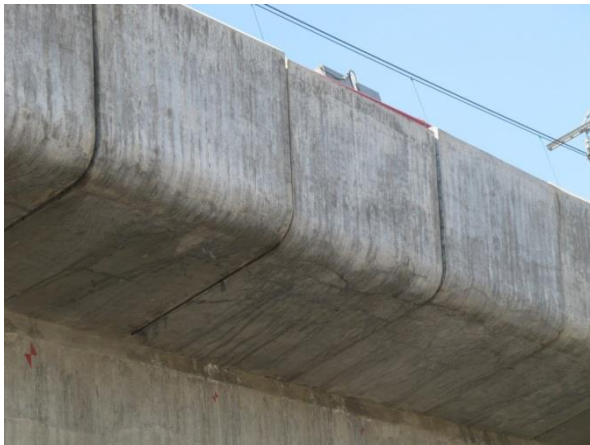
Foto 52. Irregularidad de geometría de los segmentos y tramos prefabricados
