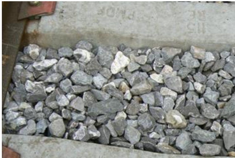
Foto 27. Balasto de tipo diferente en PK 9,030
