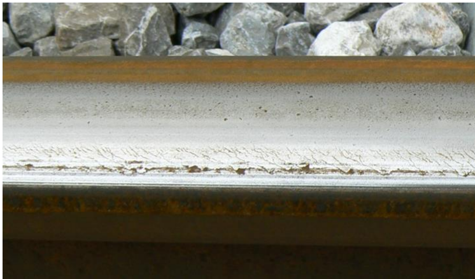
Foto 1. Head-checking vía 2 PK 12,213, cerca de Estación Periférico Oriente
