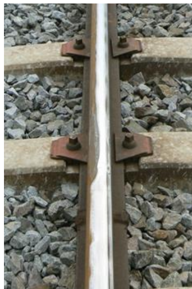
Foto 9. Soldadura PK 6,515 vía 1
