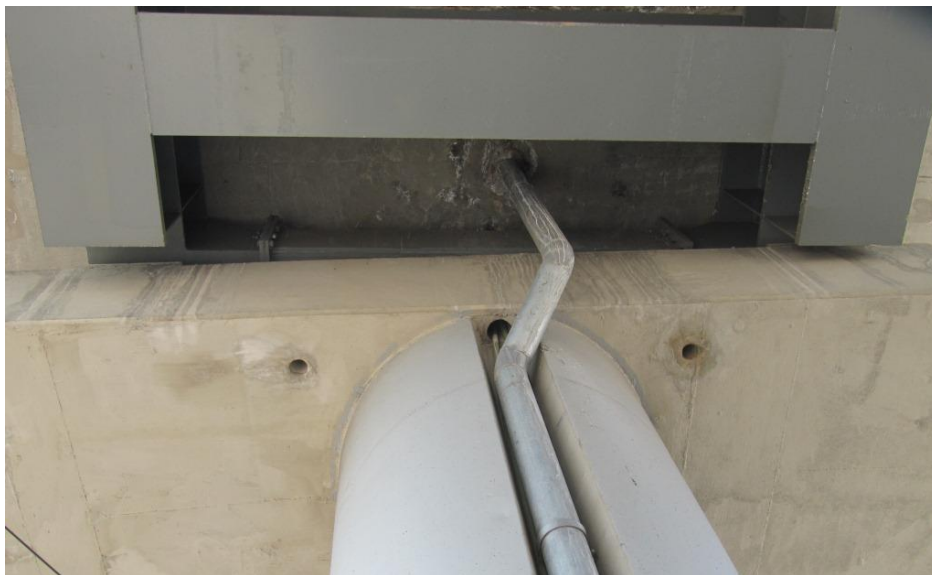
Foto 47. Drenaje con un tubo debajo de la losa
