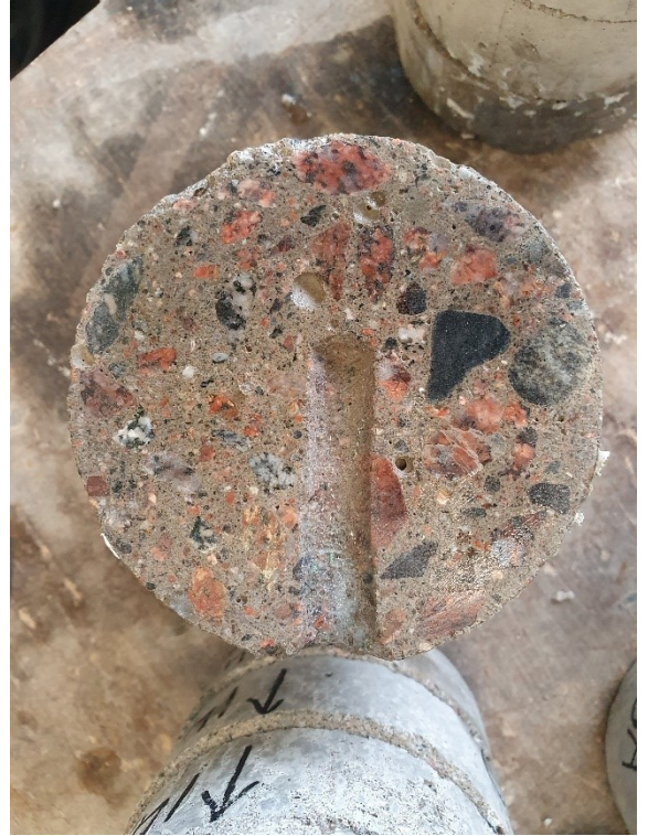
Kuva 38. Isophob-K:n injektointikohta viiden viikon imeytymisen jälkeen.
