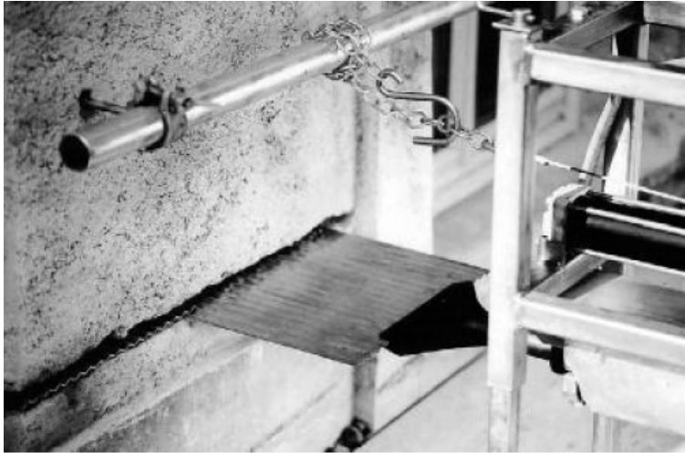
Kuva 23. Kromiteräspellin asennus paineilmavasaralla [35].
