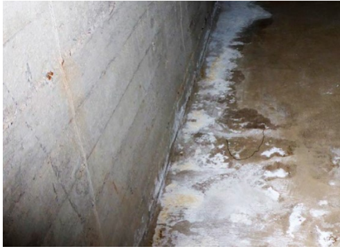
Kuva 20. Kalsiumkarbonaattia putkika- naalin alapohjan pinnalla [2, s. 140].
