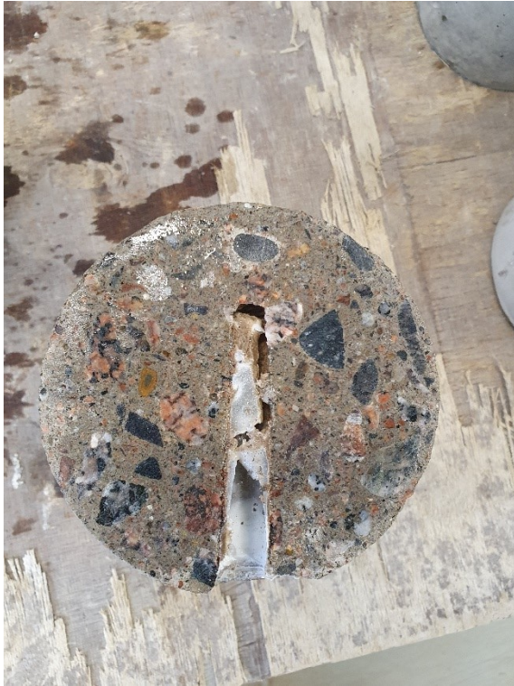
Kuva 35. Vandex IC:n injektointikohta viiden viikon imeytymisen jälkeen.
