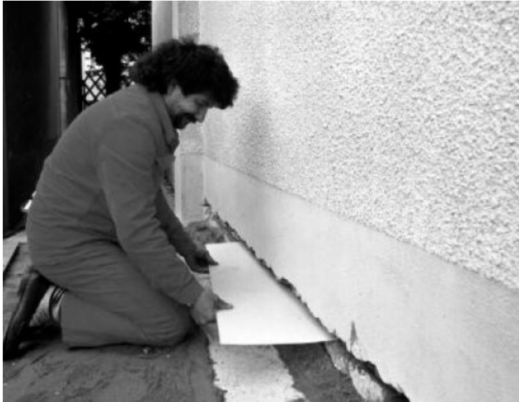
Kuva 22. Vedeneristelevyn asentaminen sahattuun rakenteeseen [35].
