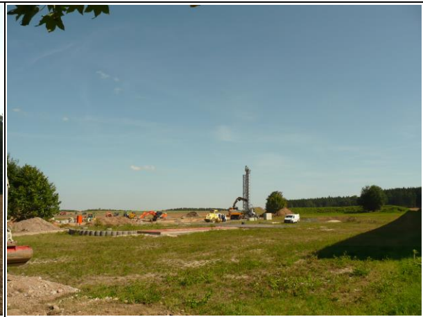
Abb. 9: Baustelle KBK Vogtlandkreis
