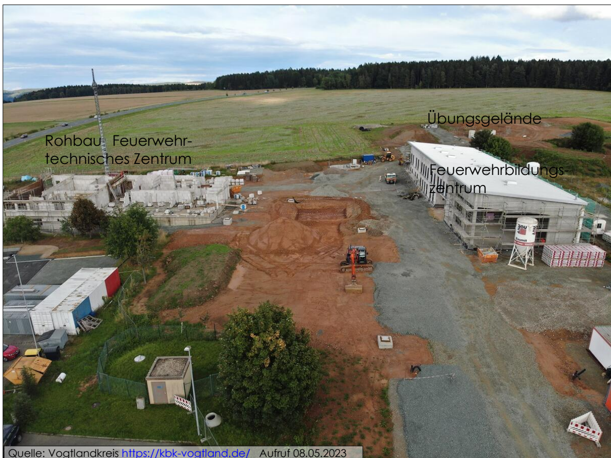
Abb. 6: Baustelle KBK im September 2022
