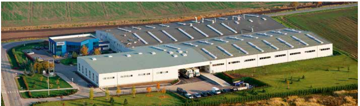
2011 - Erweiterung der dritten Halle - neues Lager und Expedition
