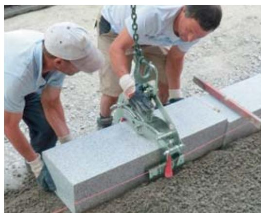
**Ausführung:** Mit Einhängeöse für Kranhaken, Schlupf oder Kette • Zwei Handgriffe für manuellen Betrieb • Austauschbare Profil-Gummileisten • Galvanisch verzinkt
