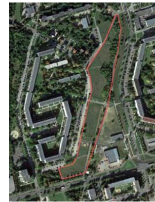
Alte Leipziger Straße (Grünau) Rückbau von Plattensiedlungen 2012- 2013 Anpflanzung von Mischwald mit Wildobstanteilen
