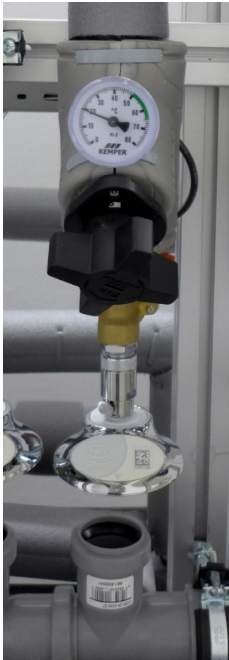
Abb. 7-7 Zapfstelle mit Pall-Filteraufnahme und Pall-Filter
