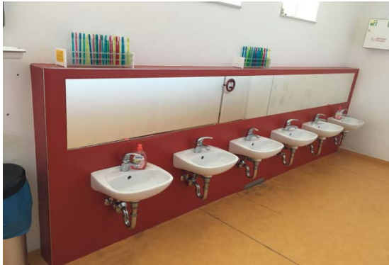
Abb. 7-33 Endständige Entnahmestellen eines der beprobten Objekte mit positivem Befund an P. aeruginosa sowohl mit kulturellen wie auch mit qPCR Analysen
