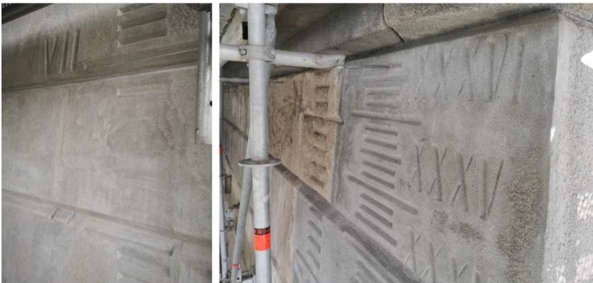
3. kép: A Lánchídi vízmércepárnak a híd felújítása során javított vagy újravésett szakaszai a felújítási munkák közben, 2022 októberében
