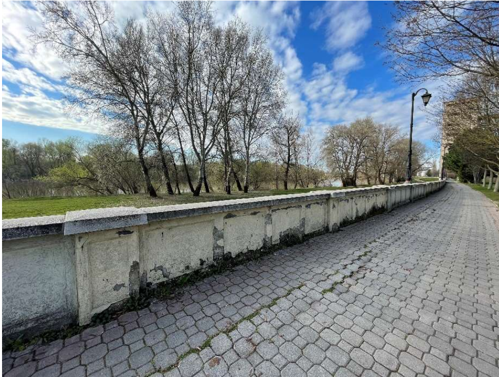
33. ábra Szolnoki árvízvédelmi parapetfal
