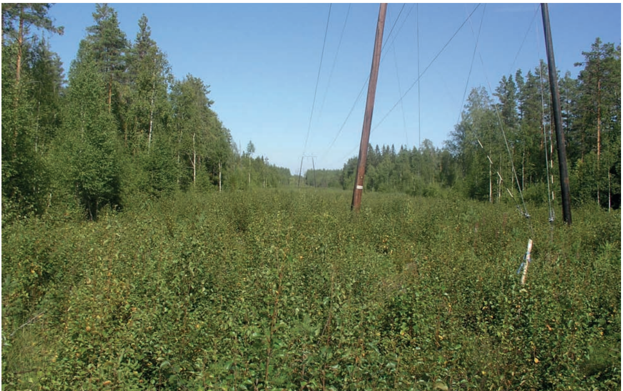
Kuva 25. Voimalinja kulkee Parinsuon halki lounaasta koilliseen. Kuvanottopaikalla turpeen paksuus on 1,6 m ja turpeen alla on vielä liejua 0,4 m ennen moreenipohjaa. Kuva: Reijo Rantapelkonen, GTK 2006.
