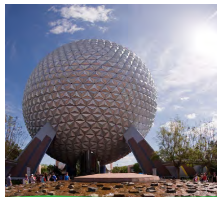
Fig. 14. Cúpula geodésica Edificio Spaceship Earth de Epcot, en Orlando.
