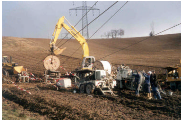
Abb. 5.9: Seilaufzug bei M 226, Goldberg, nördlich von Zillingtal. LE 42, V 3
