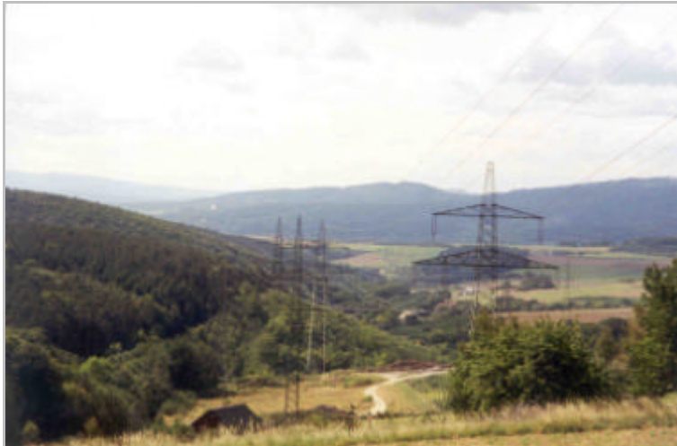
Abb. 5.7: M 1162, Blick Richtung Süden zum Tal des Siegrabenbaches, LE 233, 235, 27, 28; V 8. Parallelführung von 380 kV-Leitung Verbund und 110 kV-Leitung BEWAG
