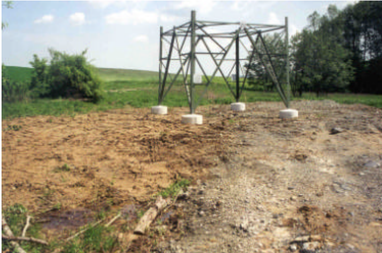
Abb. 3.19: M 106, „Zigeunergraben“ südlich von Weingraben, LE 52; Zustand während der Bauführung, April 1999
