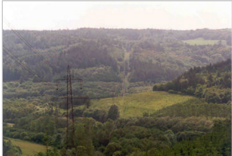
Abb. 5.3: Mariasdorf, Trassenverlauf im Birkenwald, LE 298, 299; Nadel- und Laubmischwald; die 380 kV-Leitung verläuft parallel zur (abgetragenen) 110 kV-Leitung (Bildmitte)
