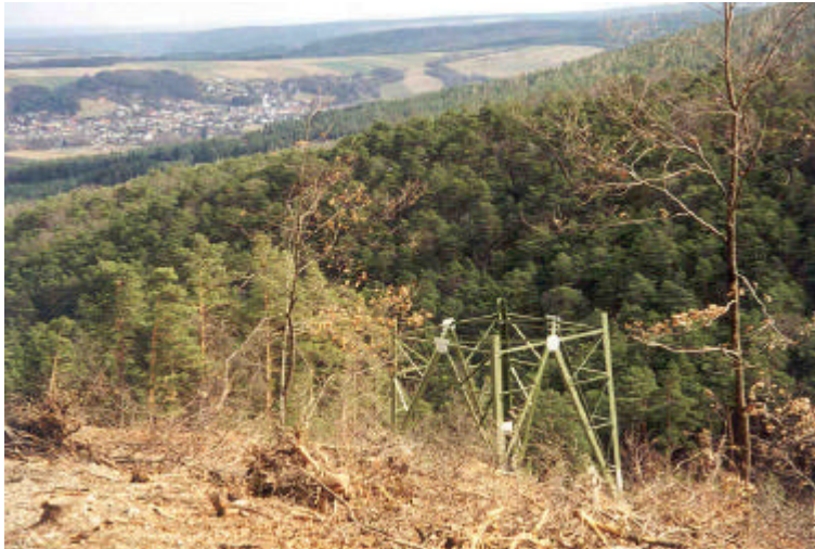
Abb. 5.4: Blick vom Waldgebiet am Saurüssel Richtung Redlschlag, Gemeinde Pilgersdorf; M 1079, V 15
