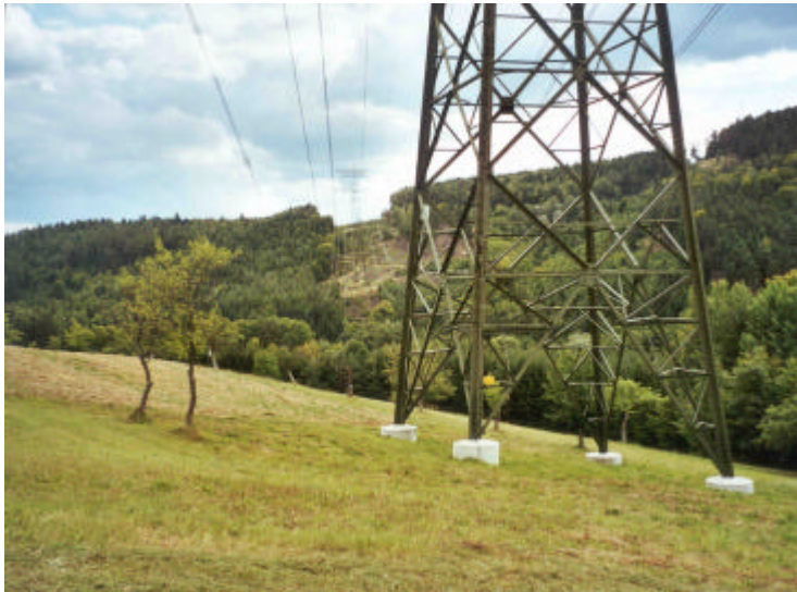
Abb. 3.16: M 1068, LE 237, westlich von Salmannsdorf; nach Bauende wieder hergestellte Glatthaferwiese; Blick Richtung Schirnitzriegel (M 1073); V 10
