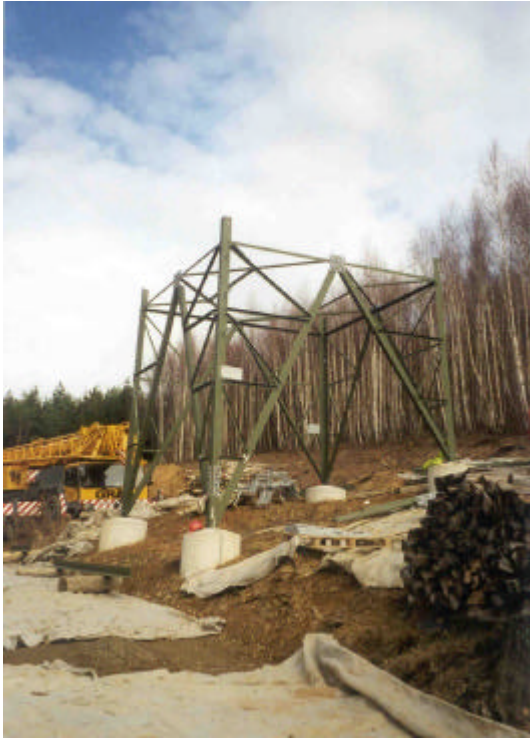
Abb. 5.10: Sicherung des Bodens durch Geotextilbahnen bei M 1069, nahe Salmansdorf. LE 241, V 16
