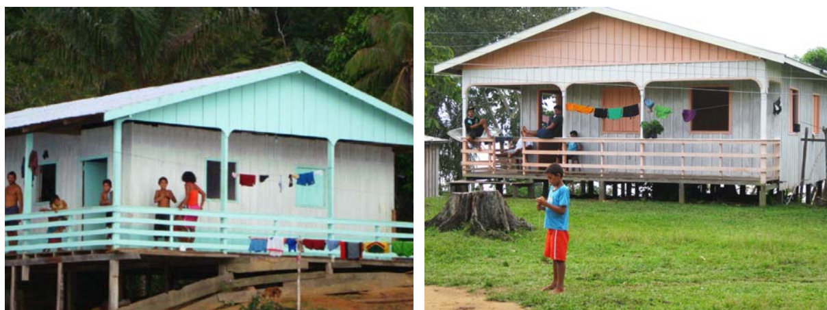
Figura 16 - Casas construídas na RESEX Catuá-Ipixuna com recursos do Crédito Habitação. (Fotos: Jeanne Gomes e Marcia Lederman).
