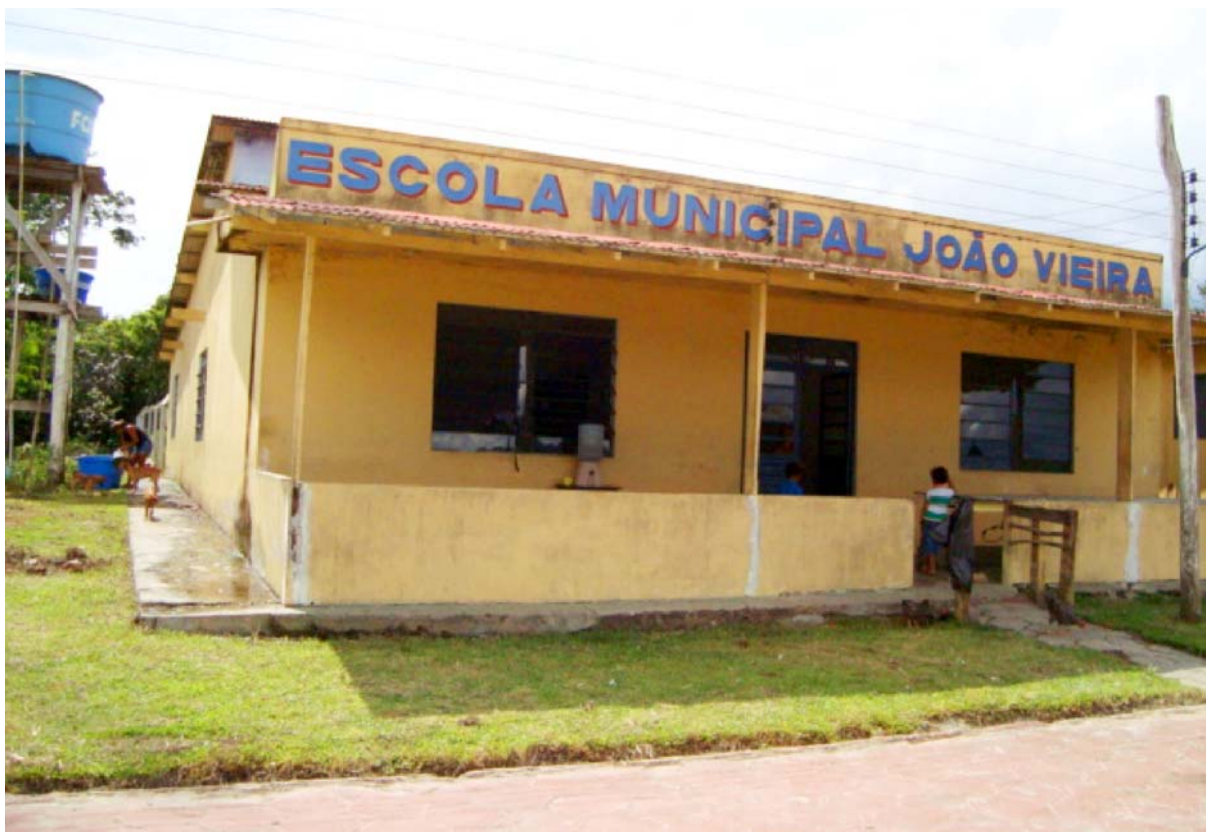
Figura 14 - Prédio da Escola Municipal João Vieira da Comunidade Divino Espírito Santo (Foto: Jeanne Gomes).
