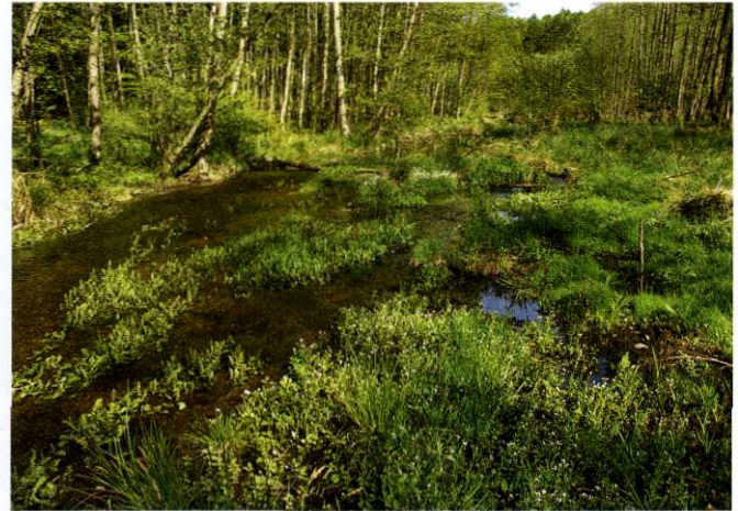
Abb. 4: Naturnahe Sohlgleite: Mittel zur Wasserstandsanhhebung in einem Fließwasserlebensraum (Kesselsee-Abfluss bei Warthe, Baujahr 2002) (Foto: Rüdiger Mauersberger, 2007)
