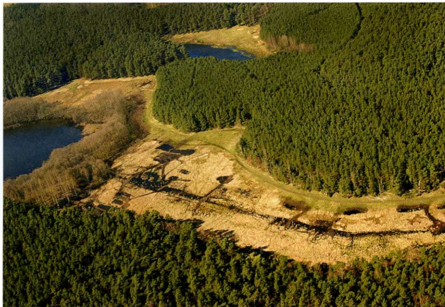
Abb. 5: Wiedervernässung eines Quellmoores mit starker Längs- und Querneigung in Torf-Querdammbauweise (Lehstsee-Niederung bei Lychen, direkt nach Bauende) mit einer Wasserspiegelanhebung von 1,5 m im Bereich des Zentralgrabens (Foto: Rüdiger Mauersberger, 2007)
