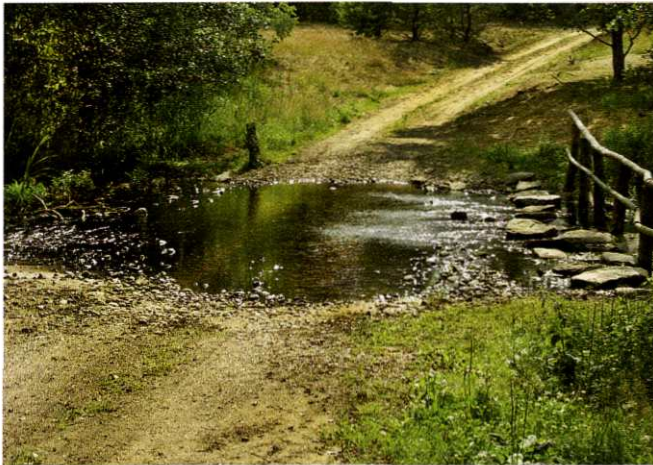
Abb. 3: Sohlgleite mit Furt an Stelle einer Brücke: Diese aquatisch durchgängige Staueinrichtung (Baujahr 2006, Kramsbeek im NSG Kleine Schorfheide) ist dank punktuelltem Bodenaustausch auch für 40-Tonner befahrbar. (Foto: Rüdiger Mauersberger, 2009)
