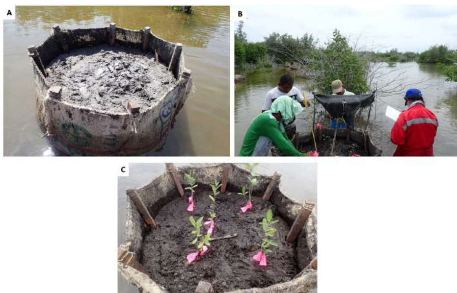
Figura 1 Aspecto general del sitio de instalación del piloto y de los montículos de restauración construidos.
