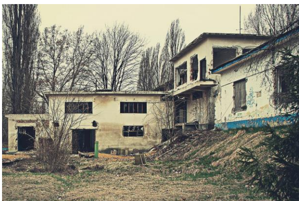
Tungsram strand leromlott állapotú épületei
