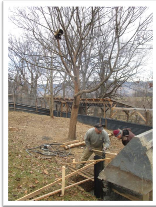
Abb. 7: Herstellung der Betonfundamente (Quelle: Mag. Beate Übelleitner)
