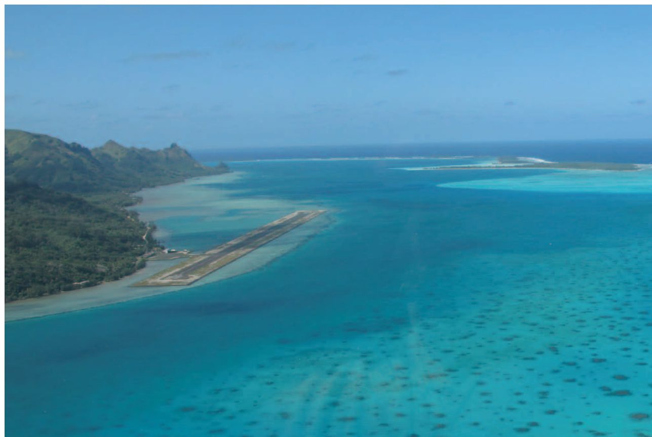
Lagon de Raivavae et remblai aménagé pour la construction de l'aérodrome. © CRIOBE
