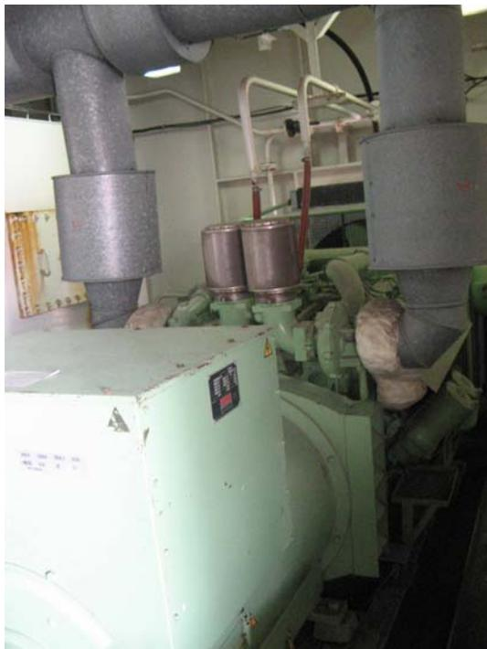
Imagen 59. Alternador del motor de emergencia.
