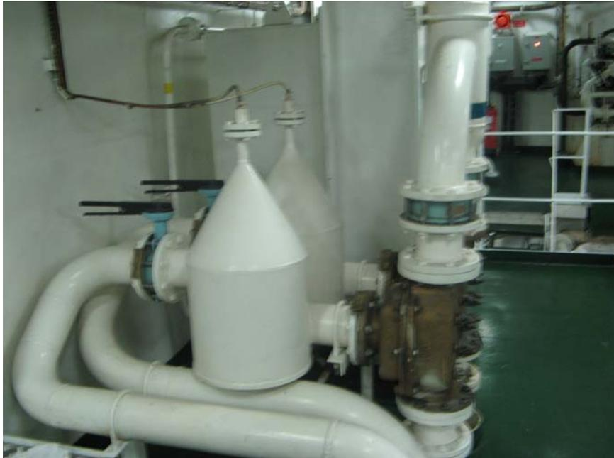
Imagen 9. Desaireador y válvulas termostáticas de agua.
