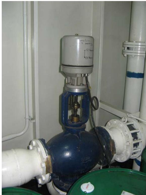
Imagen 7. Válvula termostática de regulación de temperatura.
