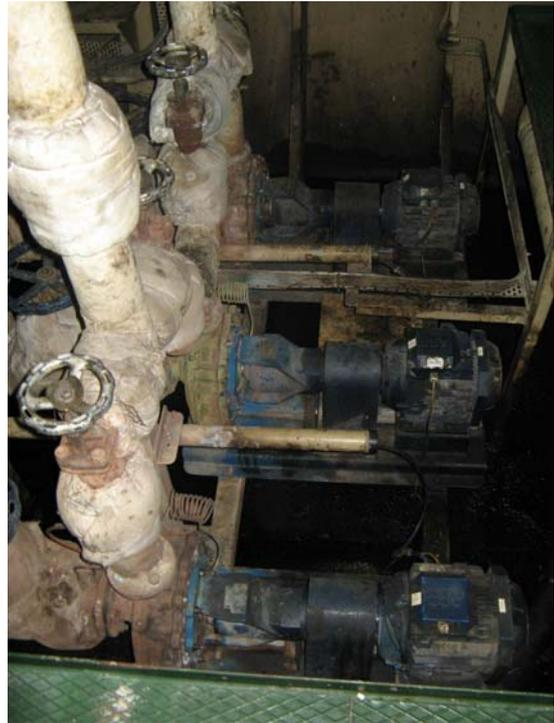
Imagen 41. Caldera y bombas de recirculación de agua de la caldera.
