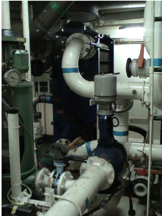
Imagen 28. Enfriador de agua motores auxiliares
