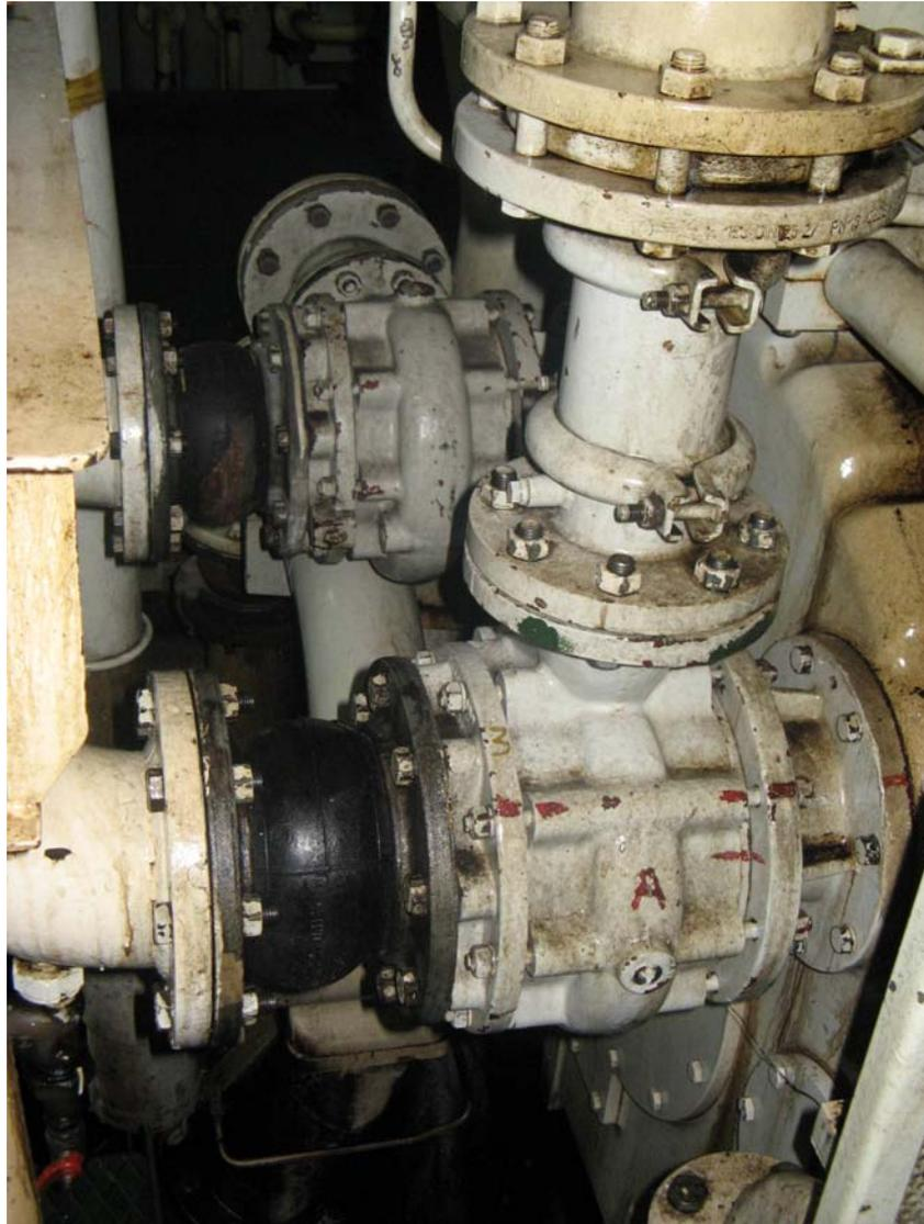
Imagen 8. Bombas de alta y baja temperatura.
