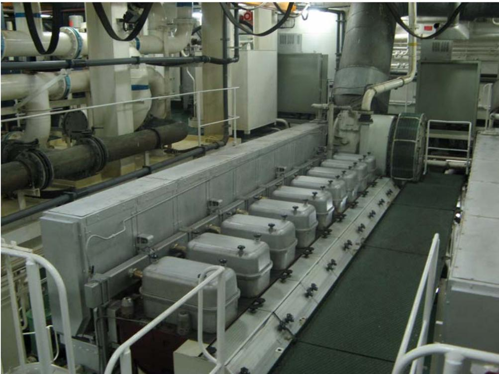
Imagen 16. Colector gases de escape.
