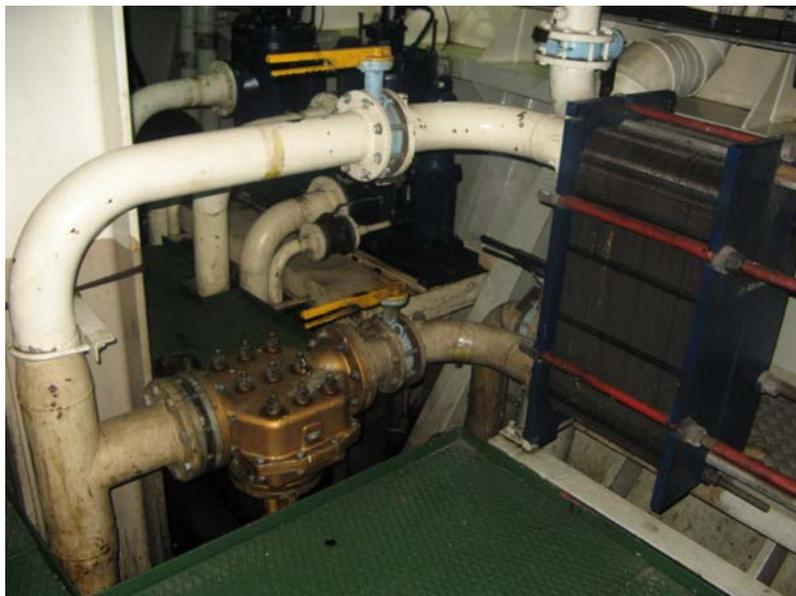
Imagen 6. Enfriador de aceite y válvula termostática.
