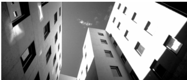
31. Interior do pátio do bloco B (F. O.)
