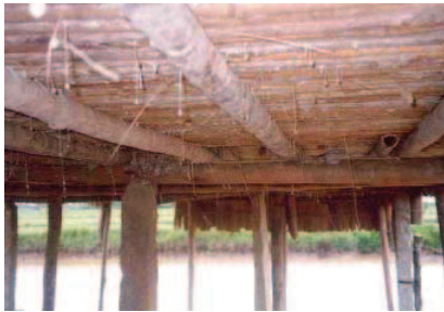
Fig. 5.5.45. Estructuración de piso, a través de vigas y pilares de bambú. Foto: T. Nguyen.
