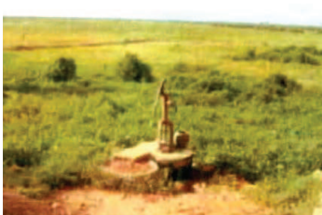
Fig.5.5.78. Pozos perforados, extracción con bomba de mano. Fuente: [10]
