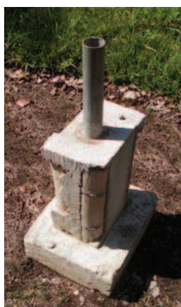
Fig. 5.5.37. Detalle tipo de dado de hormigón.
