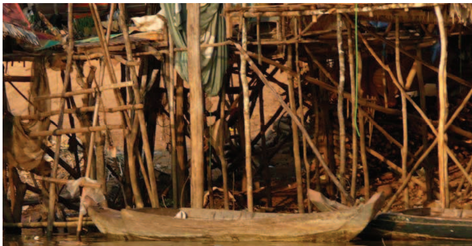
Fig. 5.5.35. Pilotes de secciones menores en la conformación de la estructura base, en la zona de estructura temporal. Foto: V. Vásquez.
