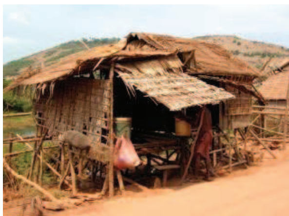
Fig. 5.5.26. Estructura ligera tipo móvil, al costado del terraplén.
