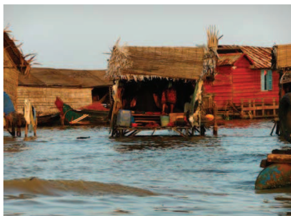
Fig. 5.5.27. Estructura ligera en la zona intermedia inferior, a tiempo de ser trasladada por la subida del agua.
