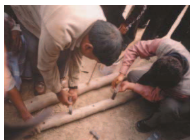
Fig. 5.5.86. Inyección de preservantes en los nodos. Fuente: Adaptado de [5]
