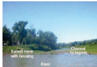
Fig. 5.1.8. Imagen del retroceso de las aguas. Fuente: [2]
