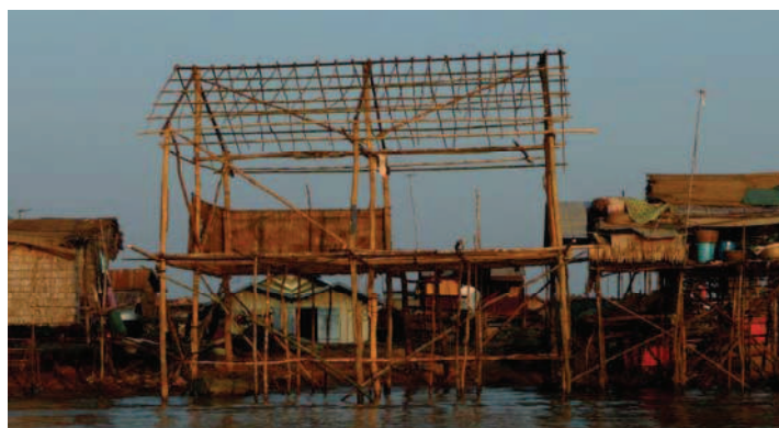
Fig. 5.5.40. Estructuración inicial que luego se ve modificada al reforzar la estructura con los cambios de locación. Foto: V. Vásquez.
