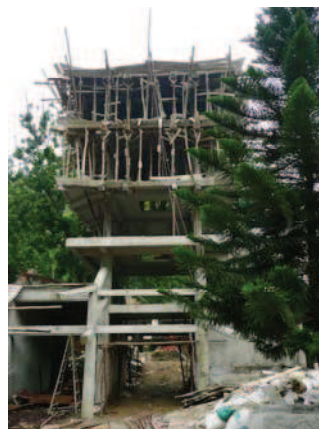
Fig. 5.3.43. Bambú utilizado en puntales para la construcción
