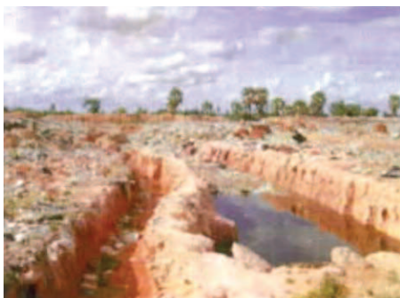
Fig.5.5.80. Vertedero y excavaciones para el almacenamiento de los desechos y su posterior quema in situ. Fuente: [10]
