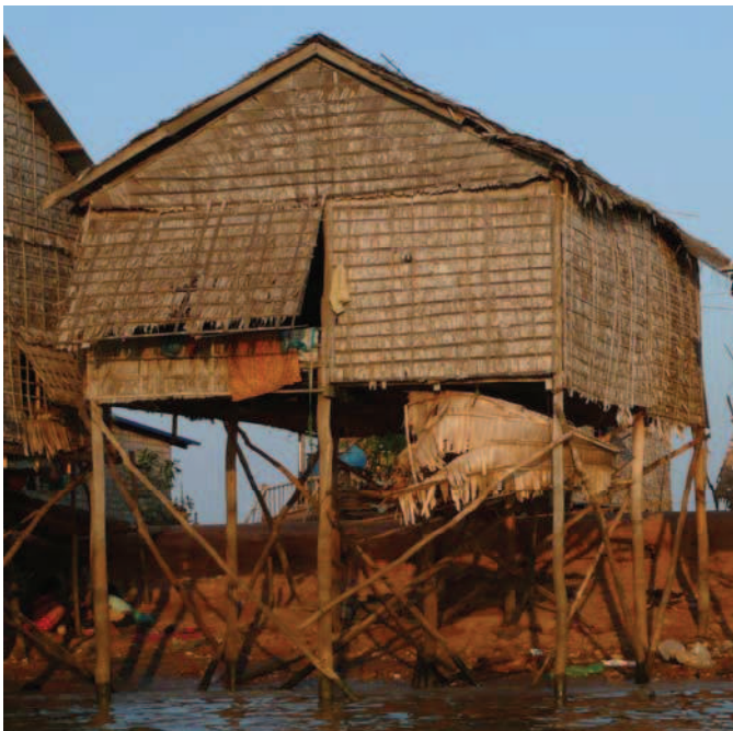
Fig.5.5.50. Movilidad de los muros-ventanas como elementos básicos de control climático. Foto: V. Vásquez.
