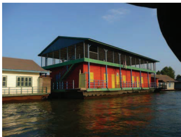
Fig. 5.4.5. Escuela flotante de Chong Kneas, aulas y gimnasio.
