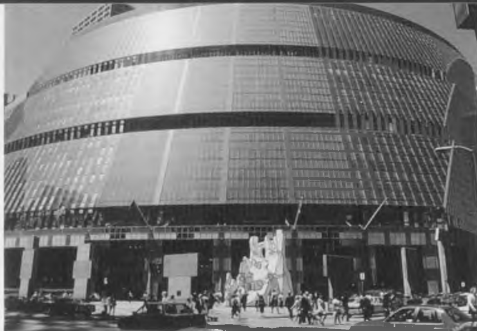
Siedziba władz stanowych
