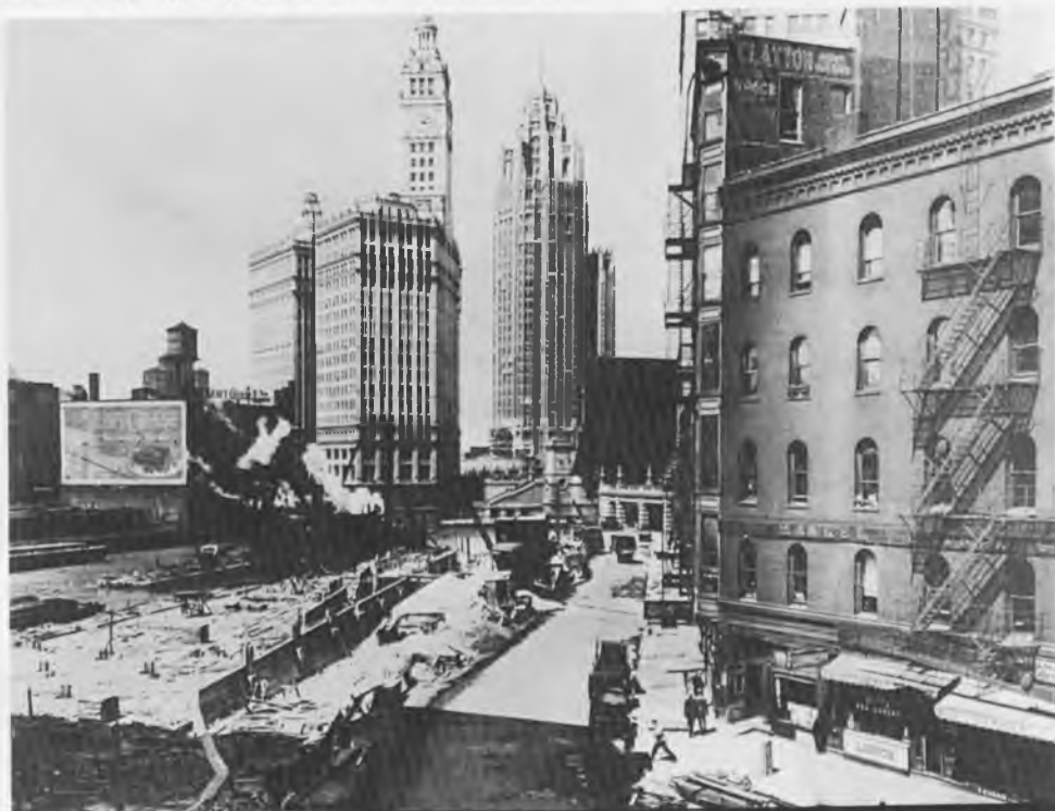
Budowa drogi szybkiego ruchu – Wacker Drive w 1923 r.
