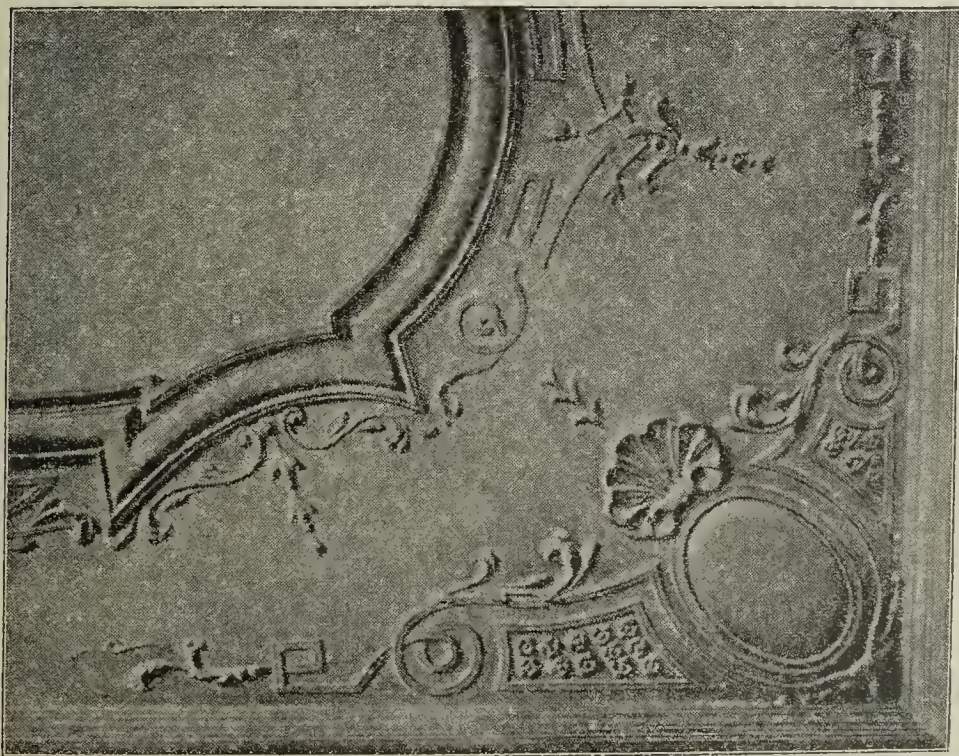
Fig. 49. Fra et Stukloft i den nedrevne Ejendom Kongens Nytorv 15.
