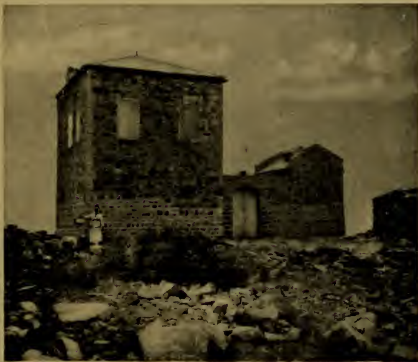
Fig. 25. — Poste optique au sommet du Ras Chergui
