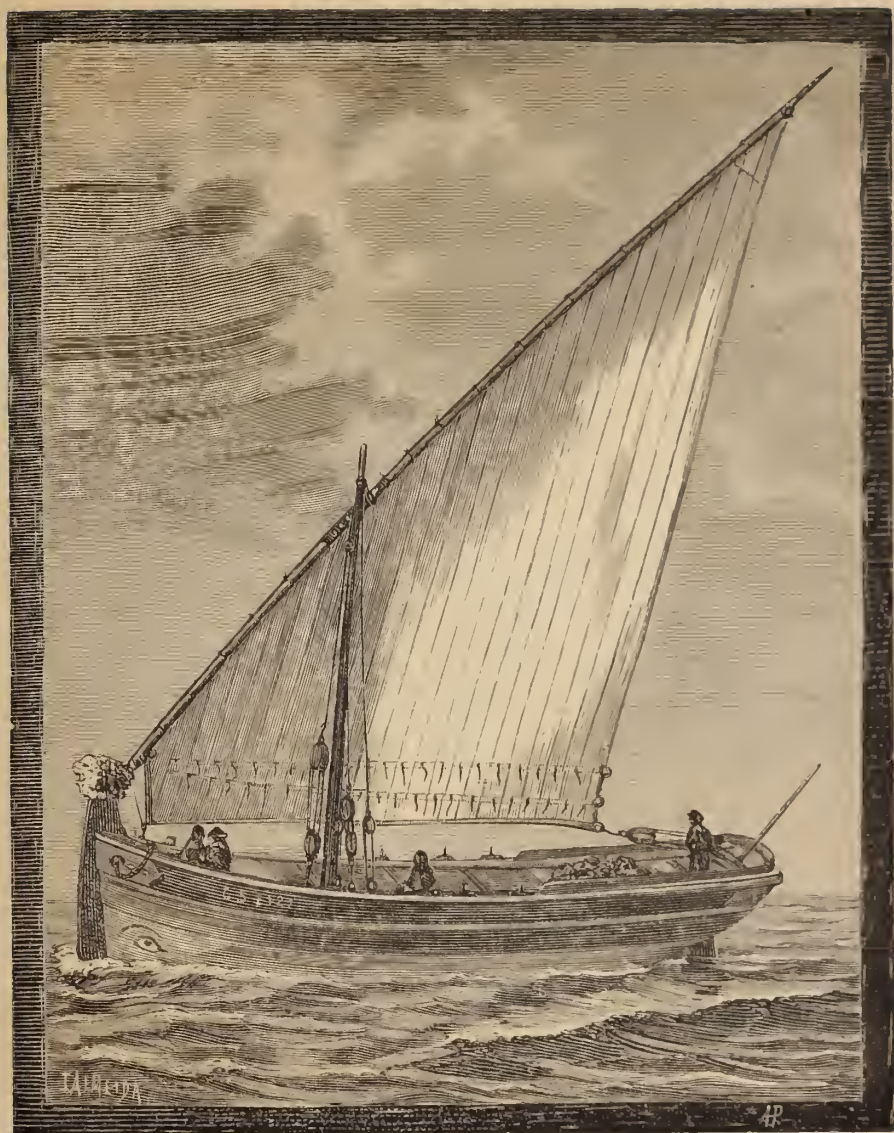
271 ILHAVO, barco para a pesca da sardinha, na costa de Lisboa (escala de \frac{1}{40} ).
