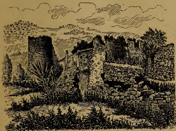
Ruinas de Bellesguart (Barcelona).
