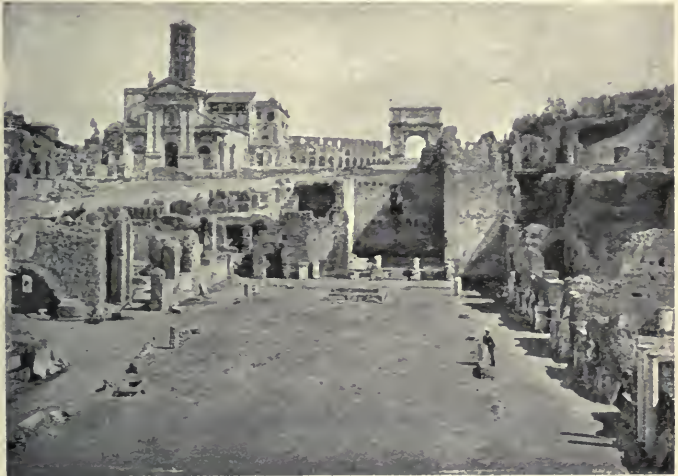
Fig. 122. The Atrium Vestae.
