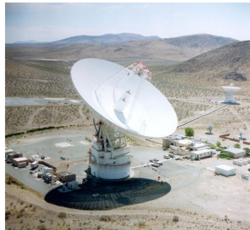
Fig. 4 Reflector parabólico para aplicaciones radioastronómicas. El reflector de la derecha de 70 metros de diámetro está situado en Goldstone (USA).
