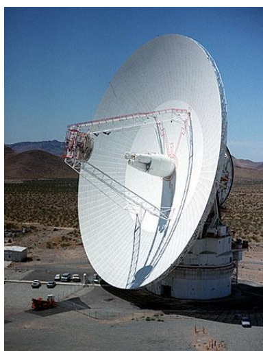
Fig. 247 Reflector Cassegrain: combinación de un reflector parabólico (reflector principal) e hiperbólico (subreflector). El reflector Gregoriano resulta de sustituir el subreflector hiperbólico por uno elíptico.
