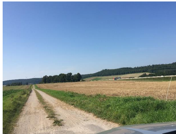
Abb. 12: auszubauender Bestandsweg, der in Richtung Nordosten nach Südwesten verläuft und im weiteren Verlauf auf die Autobahn trifft. Auf der angrenzenden Ackerfläche befindet sich der Standort der WEA 1
