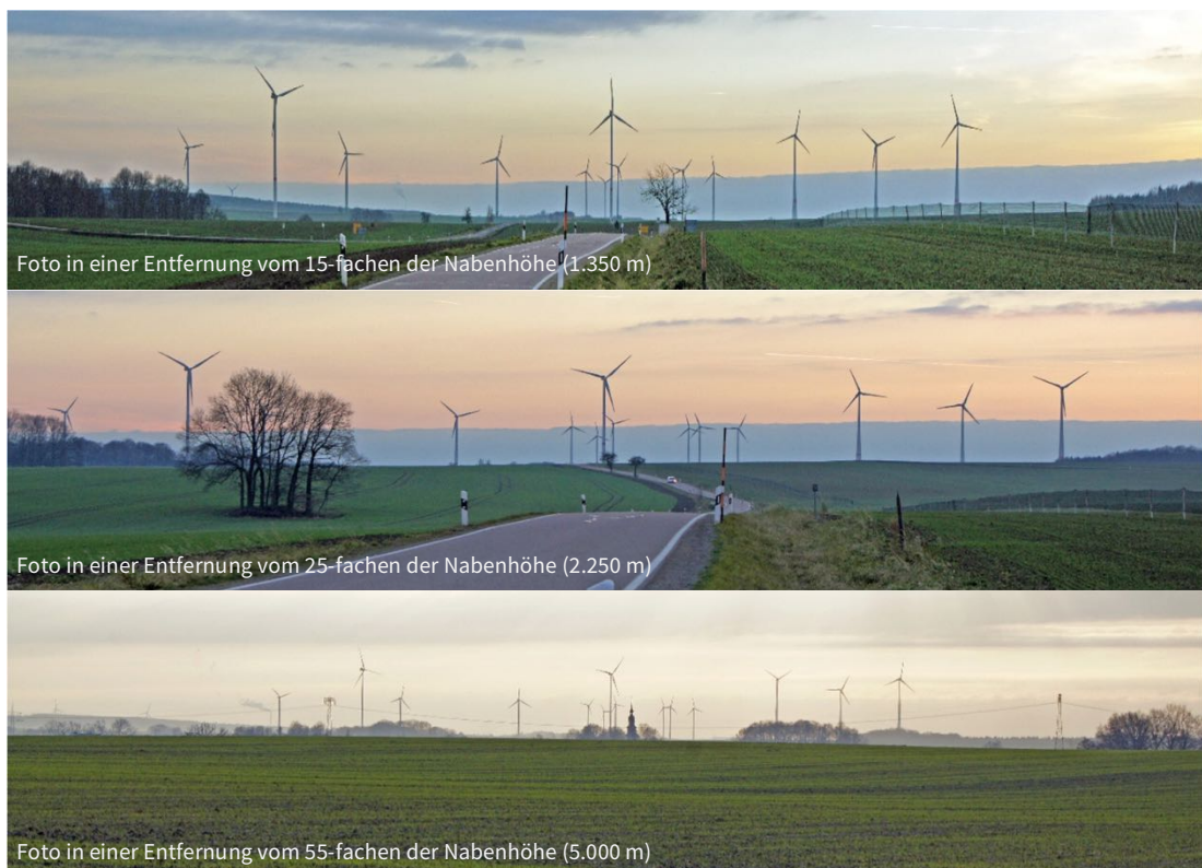
Abbildung 40 Optischer Dominanzbereich von WEA am Beispiel einer Windfarm in Mittelsachsen (Quelle: TU Dresden, Lachor © BfN (2018))
