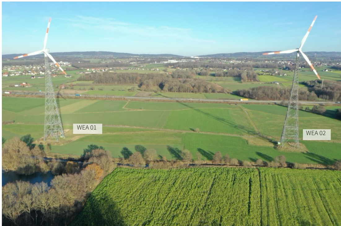
Abbildung 39 Blick auf die bestehenden WEA am Standort „Melle Bennien“
