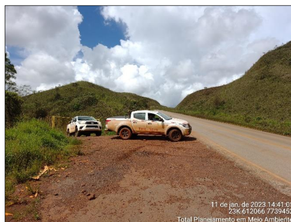
Figura 29. Trecho da rodovia MG 442 próximo a AEL.
