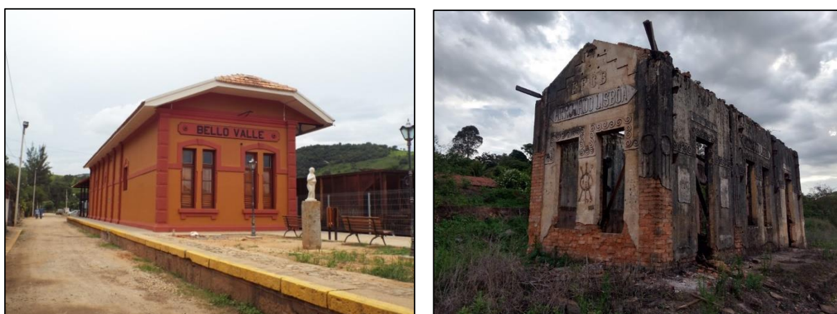
Figura 76. A Estação Belo Vale (foto da esquerda) 55 foi reformada e encontra-se em boas condições, enquanto a Estação Arrojado Lisboa (foto da direita) 56 está arruinado; essa estação homenageia o diretor da Central do Brasil, Miguel Arrojado Lisboa, na época de sua inauguração em 1917.
