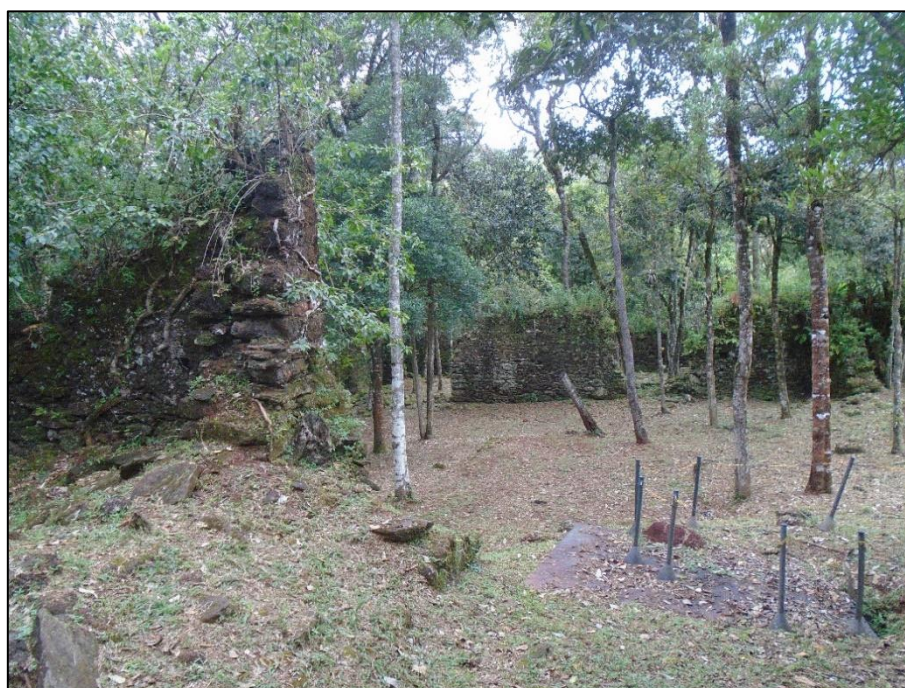
Figura 80. Vista da porção central da ruína principal.
