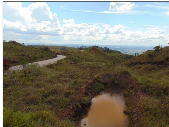
Figura 31. Vista no sentido oeste da MG - 442.
