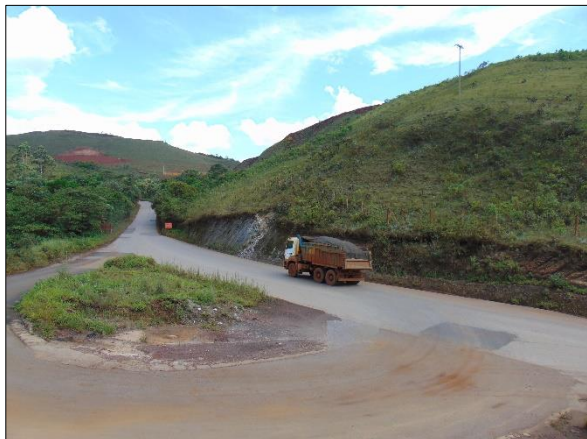
Figura 30. Vista no sentido leste da MG - 442.
