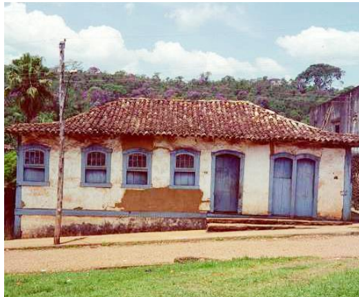
Figura 7-115 - Edificação do Núcleo Histórico de Santa Rita Durão. Fonte: IEPHA (2021)
