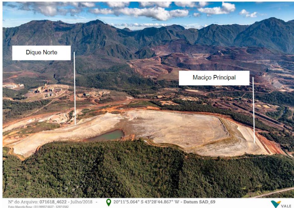
Figura 1-1 - Vista geral da barragem Campo Grande (AMPLO, 2020).
