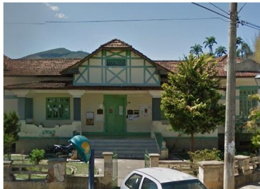
Figura 7-112 - Fachada anexo da Escola Estadual Dom Benevides em Santa Rita Durão.
