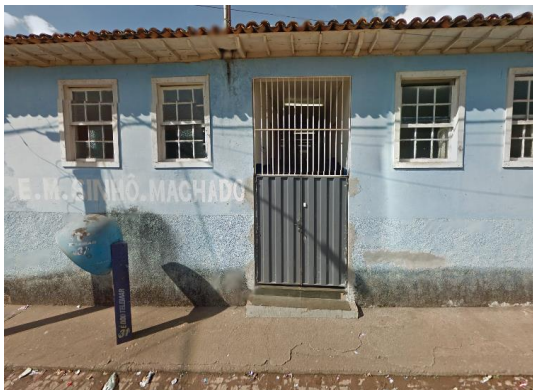
Figura 7-111 - Fachada da Escola Municipal Sinhô Machado em Santa Rita Durão.
