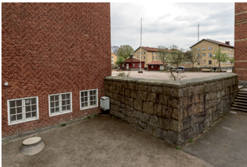
Kalkkällans läge kan lokaliseras till Norra skolan, i skärningen mellan den gamla skolbyggnaden "Slottet" och nybyggnaden "Fängelset". Det cementlock som syns i vänster bildkant täcker den brunn som i dag samlar Kalkkällans vatten som, tillsammans med regnvatten, leds genom rör ut i den närläggna Väneren. Foto: Karl Bernling.
