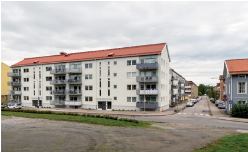
Nybyggnation i korsningen Drottninggatan/Vallgatan, på den tomt där Huvudnässkolans C-byggnad låg, augusti 2017. Foto: Karl Bernling.
